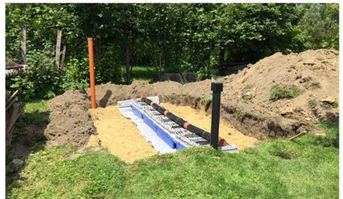
Telepítési példa, talajvíz esetén 4 főre
