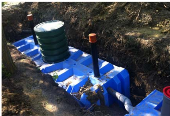
Előkezelő tartály telepítése
