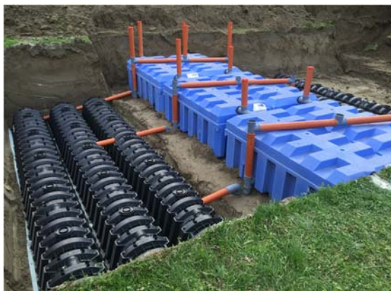
Rendszer telepítése 32 főre
