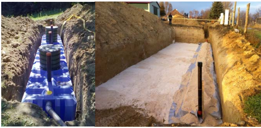
IN-DRÄN K szennyvíztisztító kialakítása 30 főre
